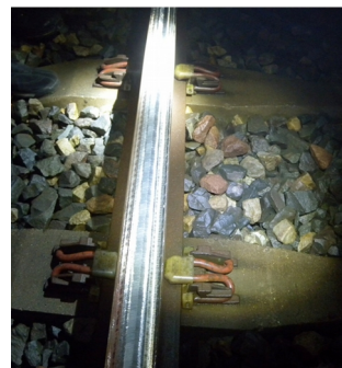
rail après meulage
