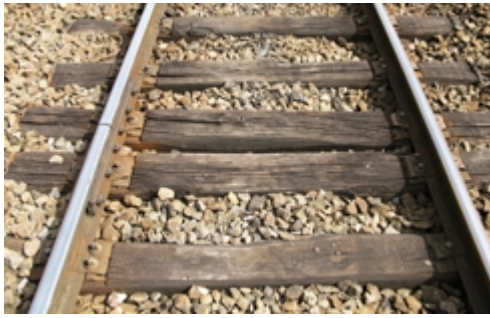
Rails courts sur traverses bois
